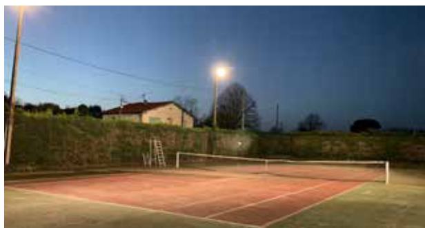
L'éclairage du court de tennis passe de 2400 W à 600 W, divisant par 4 la consommation d'électricité.
