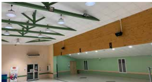
L'éclairage de la salle des fêtes passe de 3600 W à 1350 W, divisant par 2.5 la consommation d'électricité.
