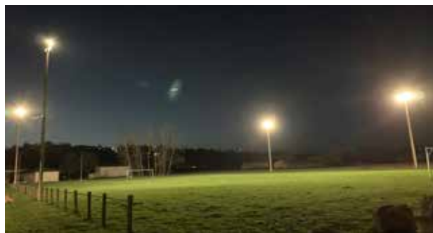
L'éclairage du stade de foot passe de 18000 W à 1800 W, divisant par 10 la consommation d'électricité.
